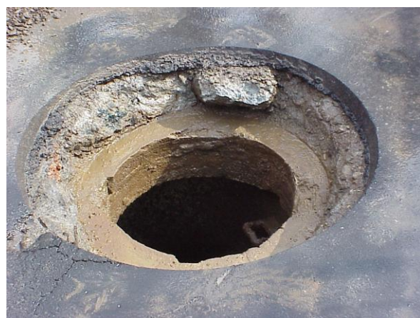
Gotowe do osadzania ramy włazu
