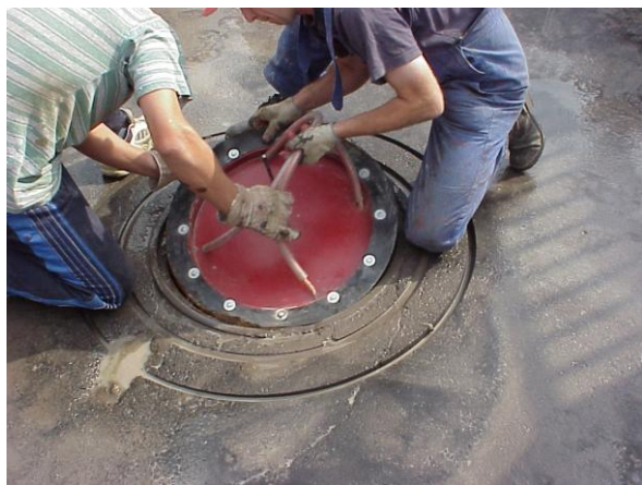
Zakładanie pokrywy blokującej uniemożliwiającej wpadanie destruktu do studni
