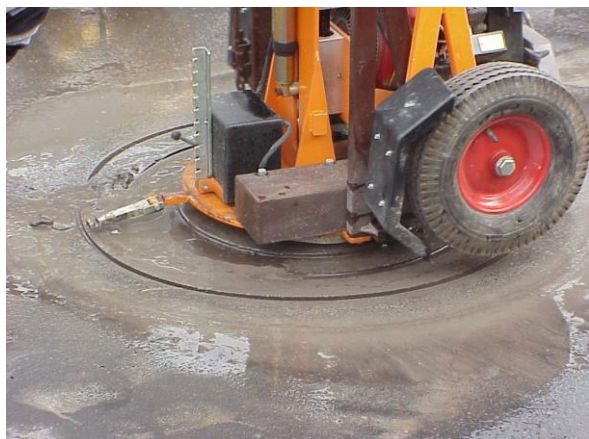
Wycinanie nawierzchni przy pomocy DS 1400
