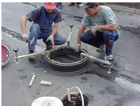
Montaż ramy poziomującej
