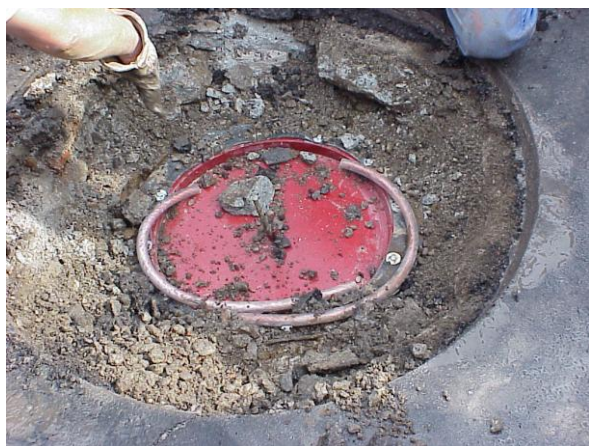
Oczyszczanie po wyjęciu ramy
