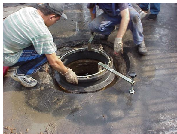
Poziomowanie włazu przed osadzeniem
