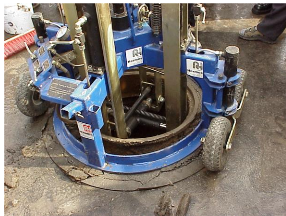
Wymywanie ramy włazu przy pomocy podnośnika hydraulicznego typ SRH – 05
